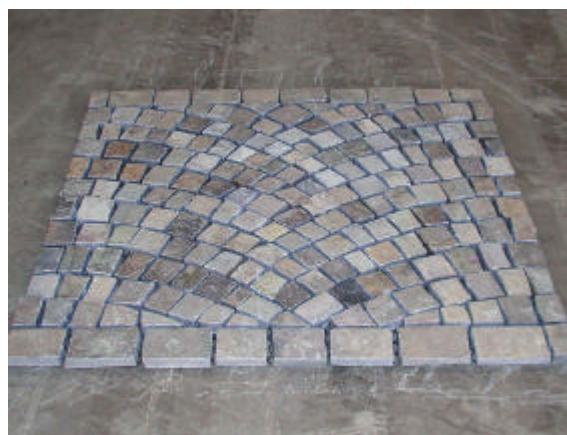
Fig. 6. Retalhos do Basalto da Serra Gaúcha utilizados para fabricação de módulos de pavimentação das calçadas.
