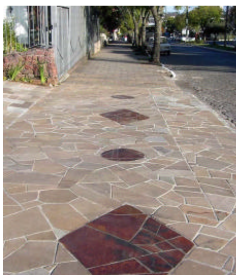
Fig. 5. Basalto da Serra Gaúcha em aplicação à pavimentação artesanal de calçada, Nova Prata, RS.
