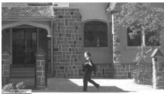
Fig. 7 - Utilização do “basalto” de várias cores para revestimento de parede e pavimentação, Caxias do Sul, RS.
